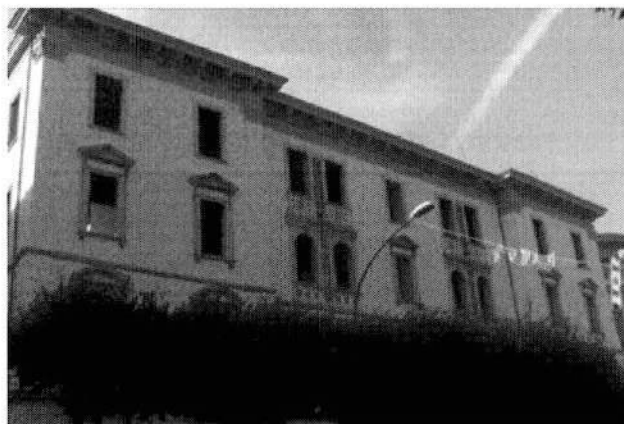
Figura 1 Ristrutturazione ex scuola Moscati
