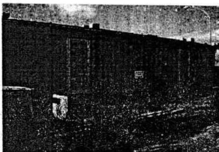
2. Edificio seminterrato al di sotto del piano di campagna per ml 0,90 a pianta rettangolare delle dimensioni ml 9,30x7,60 ed altezza ml 2,46; costruito in prosieguo del muro di c.a. di recinzione è formato da profilati in ferro e vetri; fornito di impianto elettrico, pavimentazione ed in cattivo stato di manutenzione complessiva.
